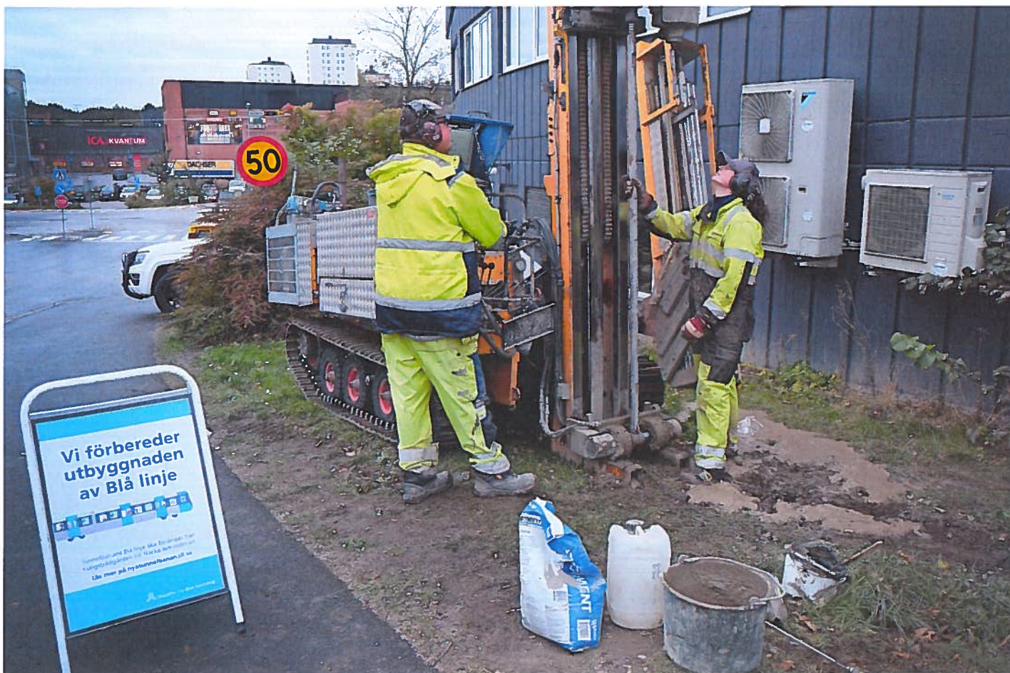
Vad finns under markytan? Nya tunnelbanans geotekniker provborrar i Sickla.
